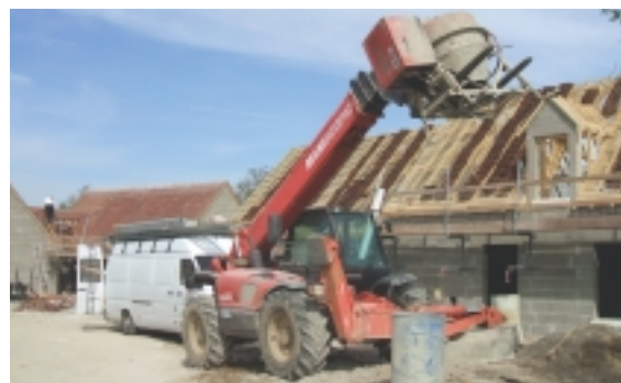
Construction du lotissement "Résidence de la Prairie"
