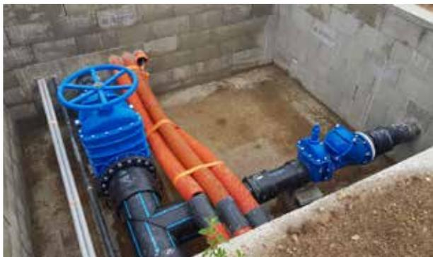
*Chambre de raccordement du réseau d'eaux usées de St-Georges à la station d'épuration à Chissay-en-Touraine.*
